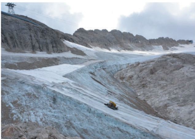
Fig. 8 - Operazioni di rimozione delle coperture geotessili alla fine della stagione estiva in prossimità della fronte di Serauta, quota 2700 m s.l.m.
